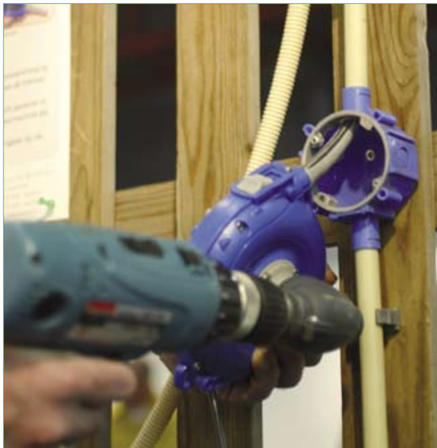
AFB. 1: De SpeedyWire drukt de trekveer met hoge snelheid door de pvc-buis.
